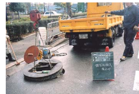
切断後クレーンで引き上げます。
