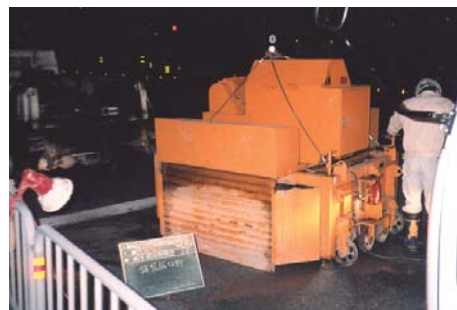
施工時はシャッターでカバーし、飛び散り防止と静音します。
